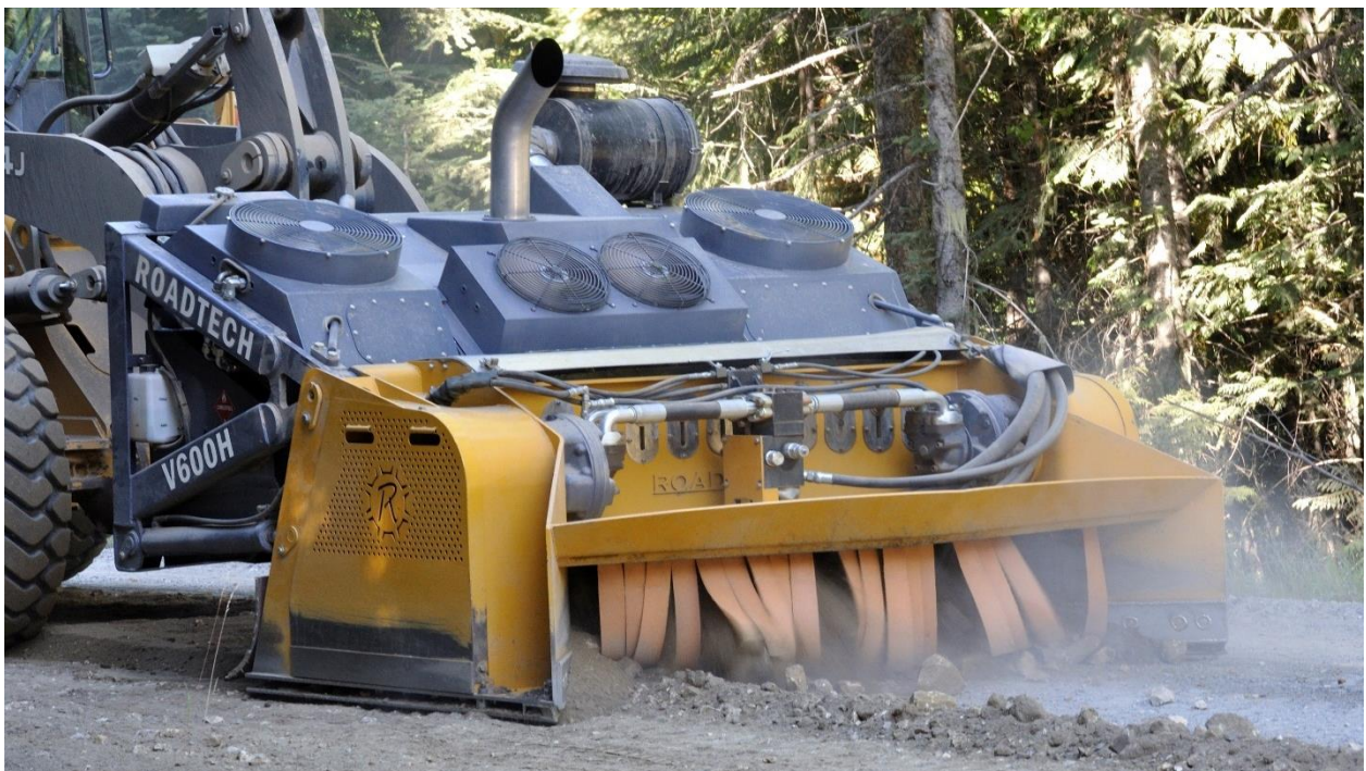
Slika 4. Metoda popravka kolnika drobljenjem kamenog materijala
