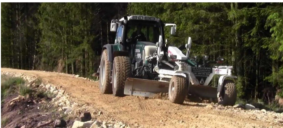
Slika 3. Metoda popravka kolnika poravnavanjem
