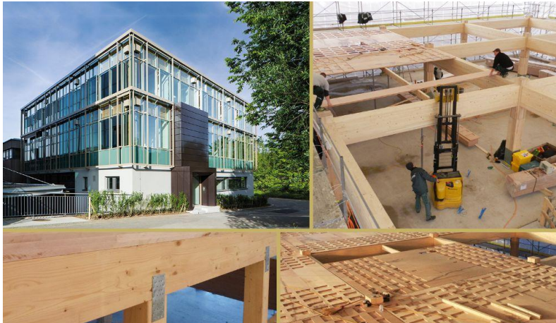
Slika 2. Prikaz pilot kuće sa inovativnim drvnim konstrukcijama
