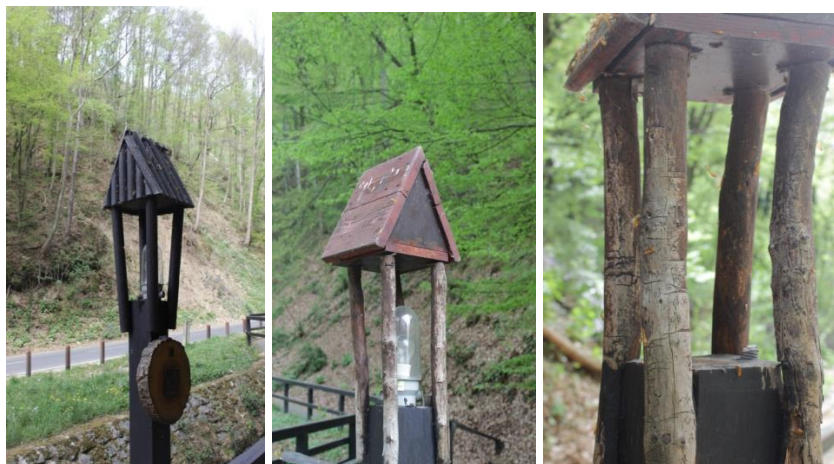
Slika 29. a) krovčić i konstrukcija izrađeni od obrađenog i obojanog drveta, b) konstrukcija jednostavnijeg krovčića izrađena od prirodnih otkorenih grana, c) detalj vidljivih tragova hodnika potkornjaka na konstrukciji krovčića (foto: Tikvić, 2016.)
