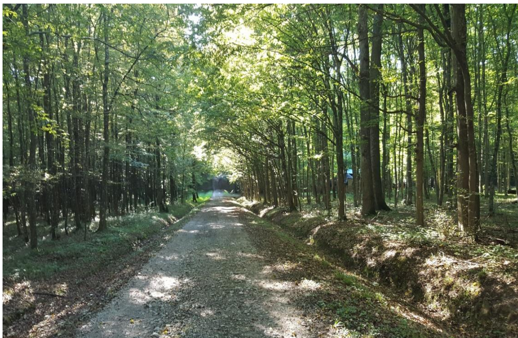
Slika 94. Pristupna cesta koja vodi granicom odjela 25-f GJ „Novakuša-Šikava“ do Ćirine kućice
