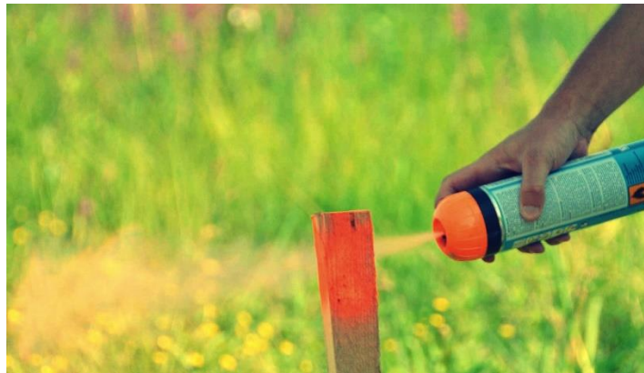
Slika 9. Početak terenske izgradnje poučne staze započinje iskolčavanjem trase
