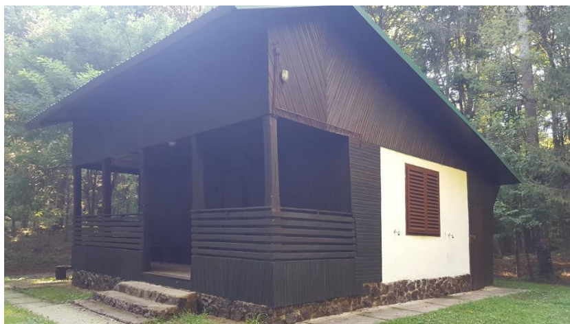
Slika 96. Zatvoreni objekt Ćirina kućica
