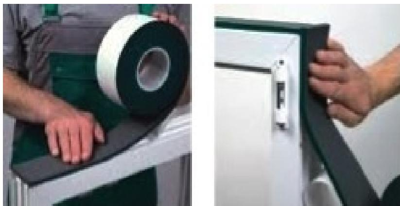
**Slika 23.** Primjer pričvršćivanja brtvenih traka „3 u 1“ na građevinski element - B)
