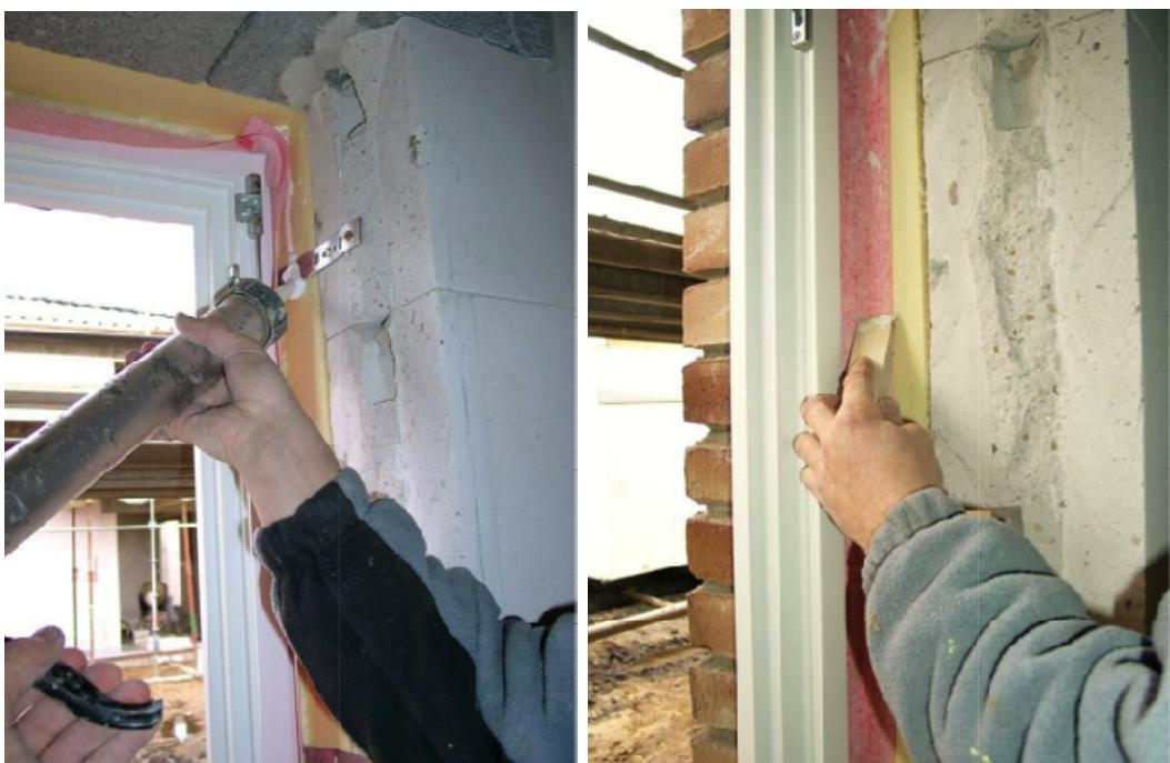
**Slika 22.** Primjer pričvršćivanja unutarnjih paronepropusnih traka na građevinski element – A) način brtvljenja. (Anonymus 7, 2016f)
