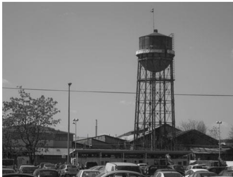
Slika 9. Vodotoranj Gredelj (DAZ, 2012.)
