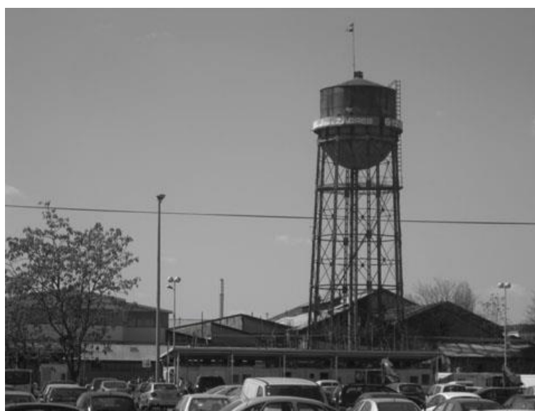
Slika 9. Vodotoranj Gredelj (DAZ, 2012.)
